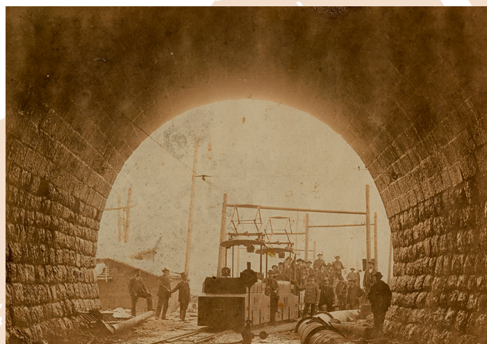
Gradnja karavanškega železniškega predora, ok. 1905. Foto: neznan. Hrani: fototeka GMJ.
