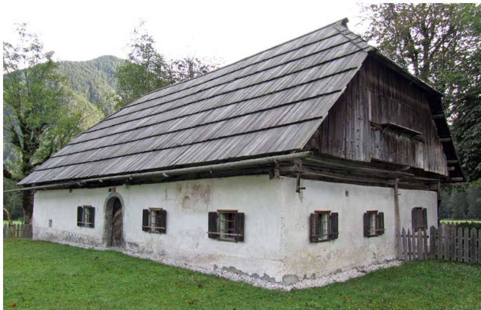
Zidan objekt ima mogočno streho s čopoma in lesena zatrepa. Vhod v hišo je le z ene strani, na vzdolžni steni. Fotografija je iz leta 2021. Vir: Triglavski narodni park.
