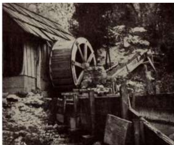
Najbolj razširjen tip vodnih mlinov pri nas z navpičnim vodnim kolesom
